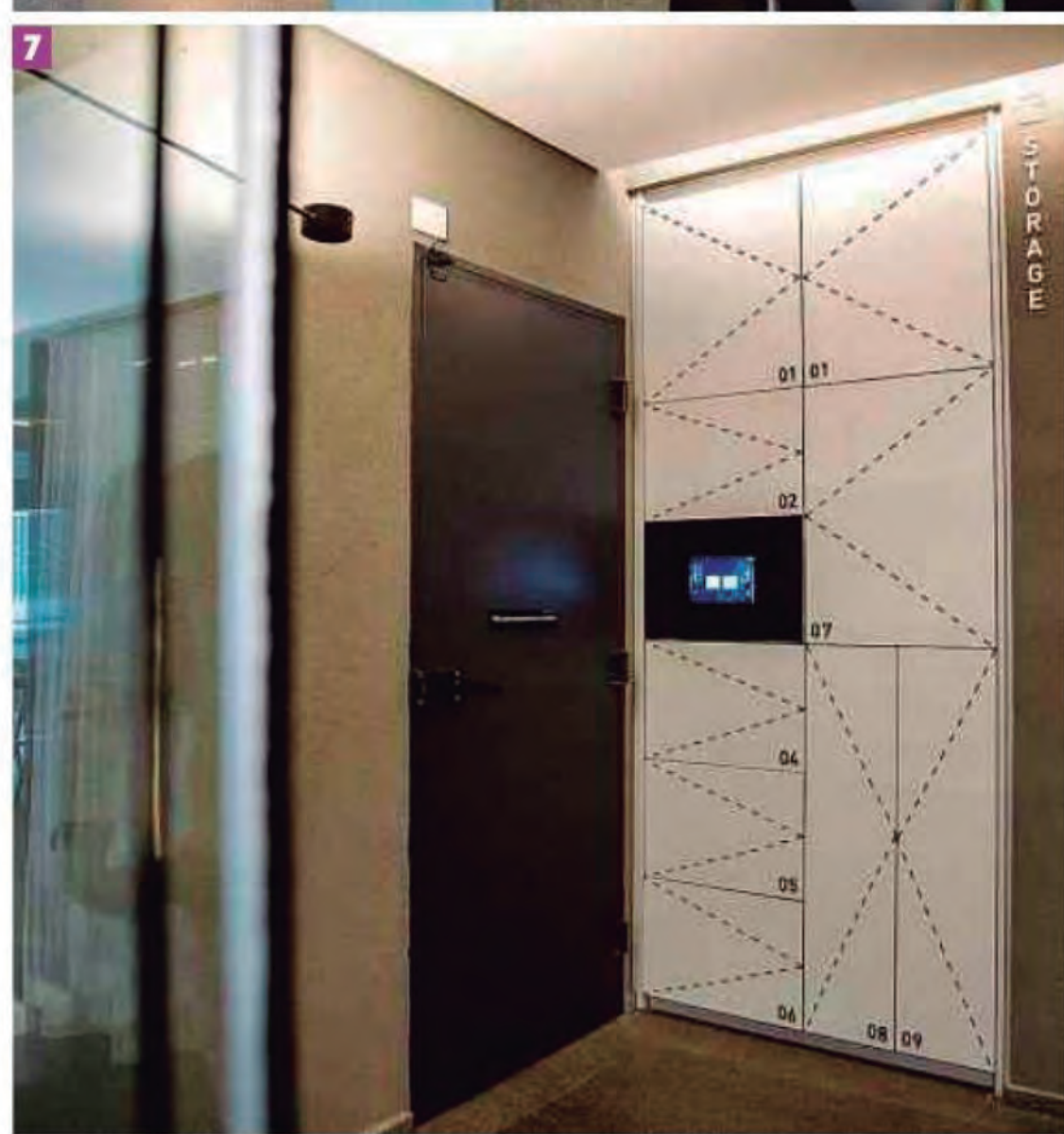
Portaria de empreendimento da SKR em Moema, com botão de pânico e controle das imagens das câmeras de segurança 6 ; prédio inclui armários para receber entregas com fechadura inteligente acionada por QR Code 7 e fechaduras eletrônicas com senha nos apartamentos 8
